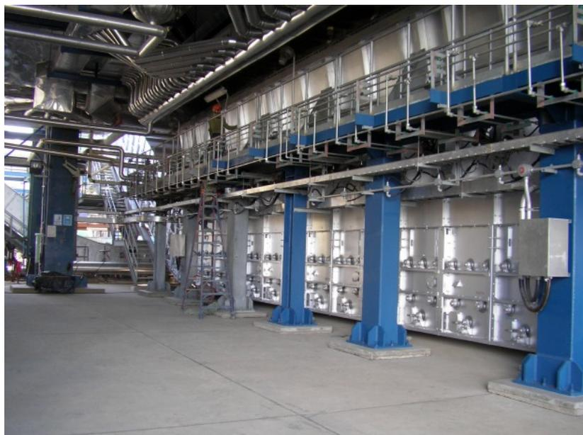
*Figura 26 Sistema di estrazione delle ceneri pesanti*
