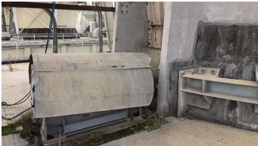
*Figura 24 Motore riduttore ventilatore torre evaporativa*
